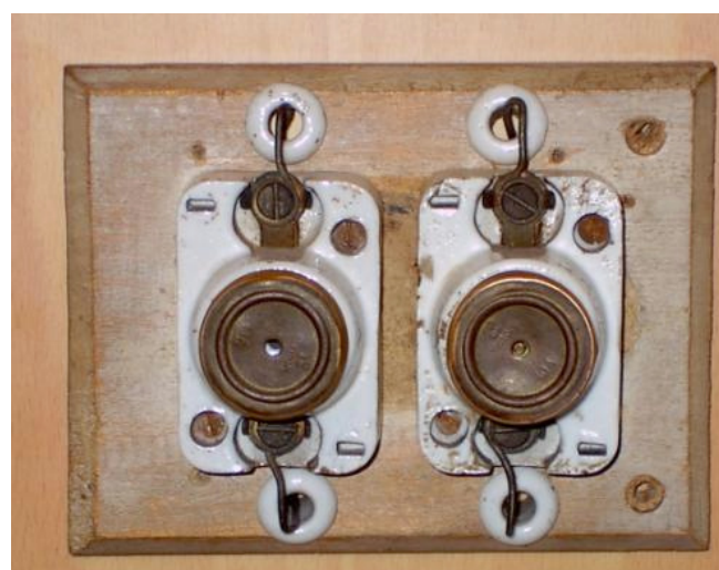
Fotografía 2.2. Fotografía de “los plomos”, el antiguo cuadro de control.
