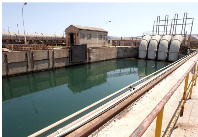
Fotografía 2.3. Ejemplo de una piscina de decantación de agua de mar.
