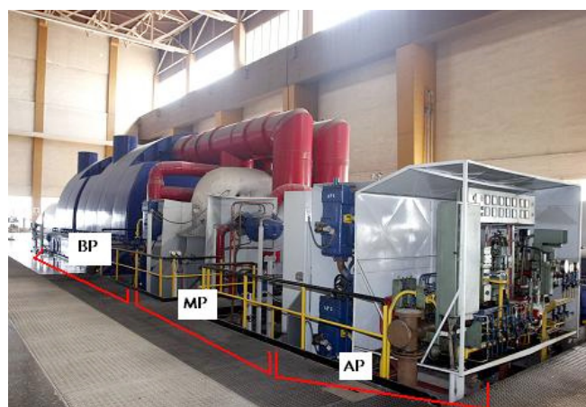
Fotografía 2.1. Ejemplo de una turbina de vapor con sus cuerpos de distinta presión.
