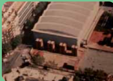
Fotografia 2.3. Exemple d'una subestació totalment sota terra. Es veuen les columnes de refrigeració.
