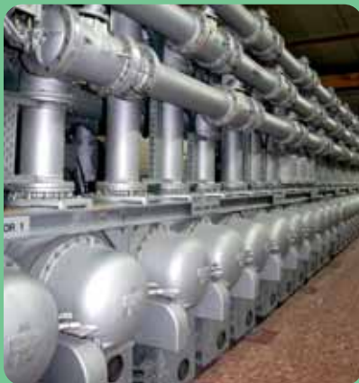
Fotografia 2.2. Part d'una subestació (sala d'interruptors d'alta tensió)
