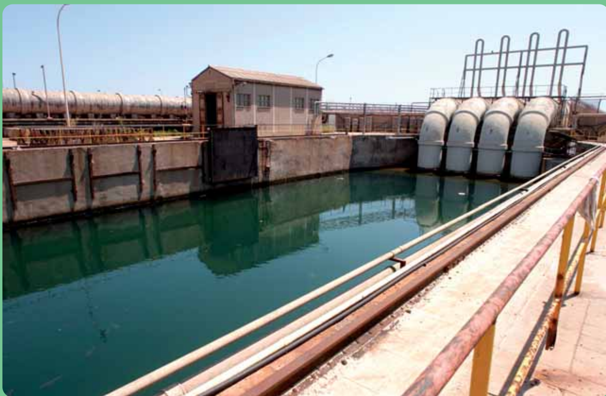
Fotografia 2.3. Exemple d'una cambra de decantació d'aigua de mar.
