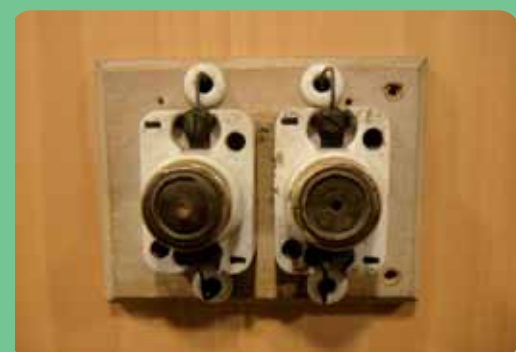
Fotografia 2.2. Fotografia "dels ploms", l'antic quadre de control.
