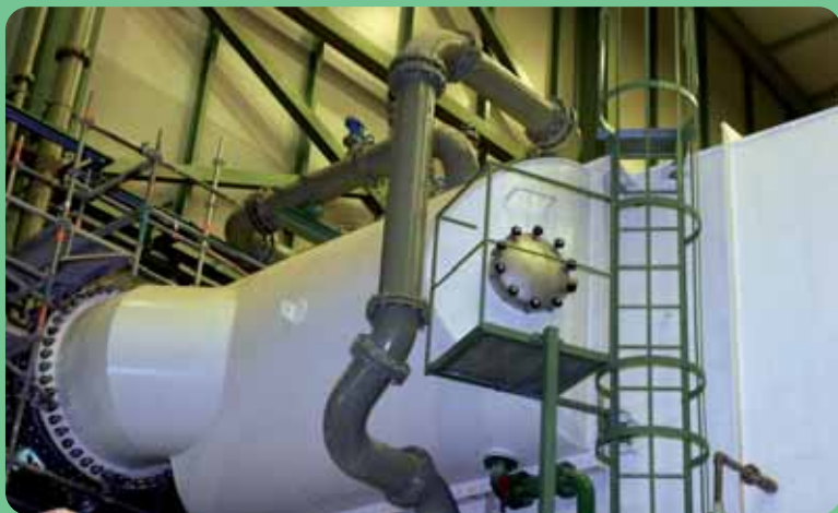
Fotografia 2.4. Exemple de condensador.
