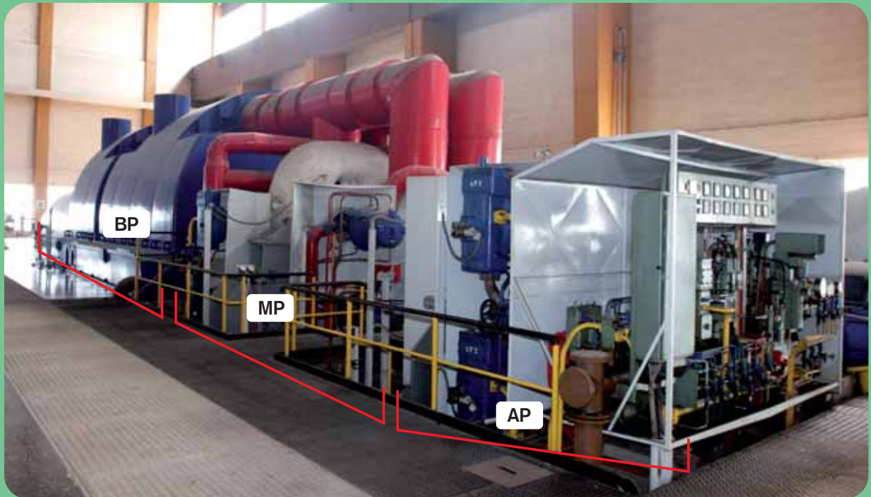
Fotografia 2.1. Exemple d'una turbina de vapor amb els seus cossos de diferent pressió.
